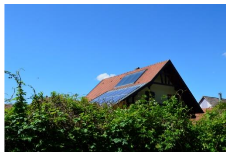
Exemple de panneaux solaires
