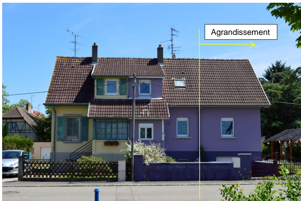
Caractère évolutif des maisons à destination des ouvriers
