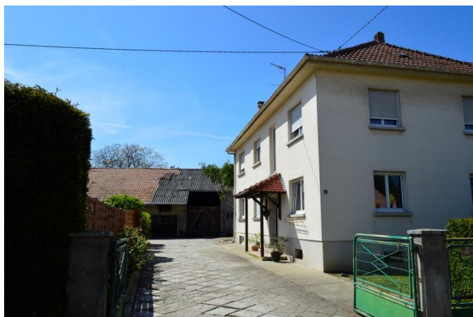
Maison réhabilitée avec isolation extérieure
