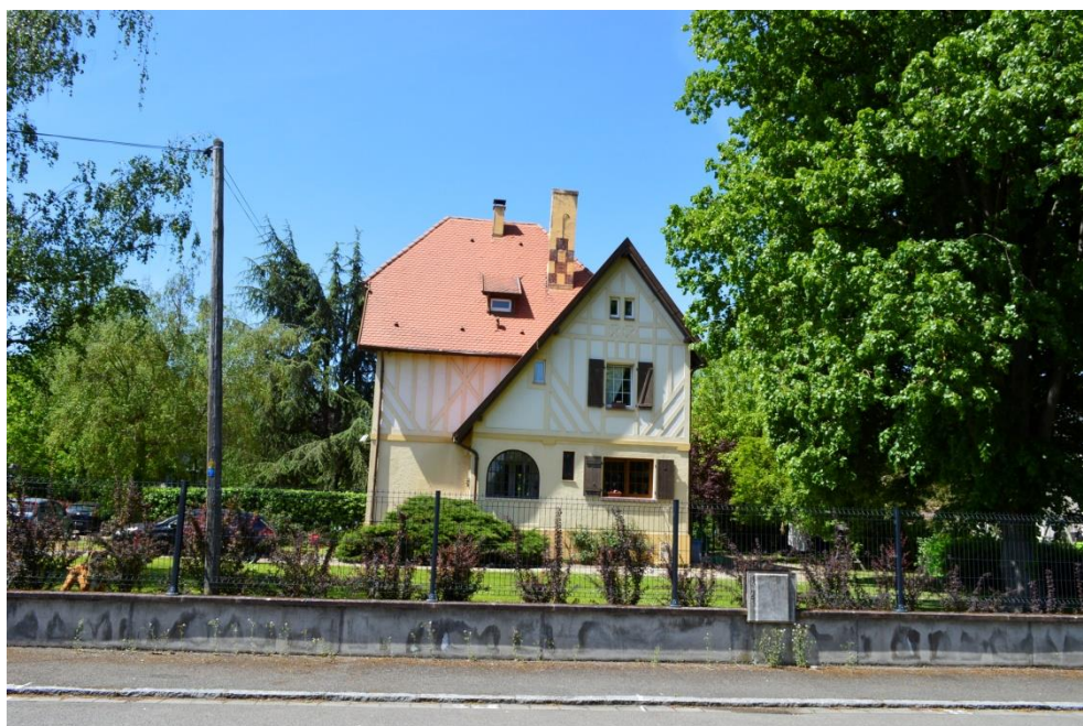
Maison d'habitation à destination des ingénieurs
