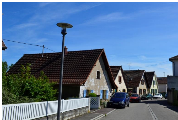
Maisons à réhabiliter
