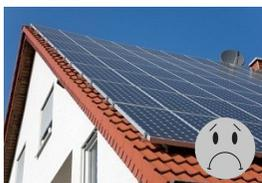
Les panneaux solaires sont mis en place **directement sur les chevrons**, afin d'**amoindrir l'épaisseur des panneaux sur le toit**.
